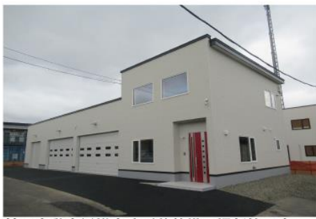
神田自動車(株)様事務所兼整備工場新築工事
