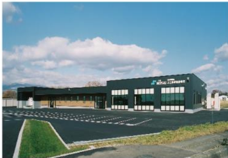
十勝農業共済組合 北西部事業所 上土幌家畜診療所 新築工事
