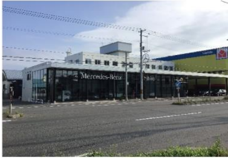
東北海道ヤナセ株式会社ショールーム増築工事
