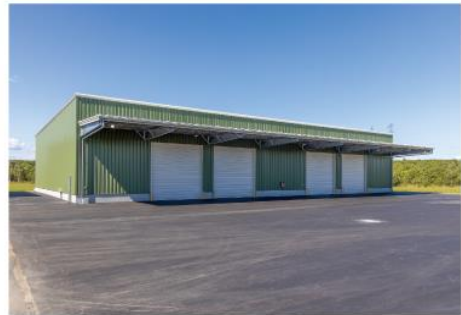
ワールドグリーン株式会社様 倉庫新築工事
