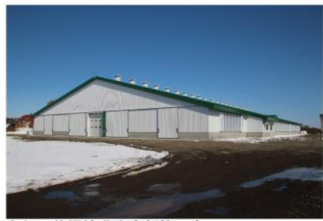
久保田牧場搾乳牛舎新築工事
