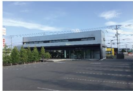
ALAMODE head 新築工事
