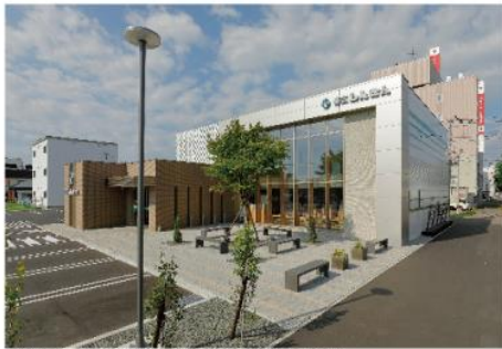
帯広信用金庫 東支店改築工事
